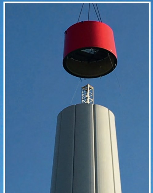
Der Konus wird aufgesetzt
